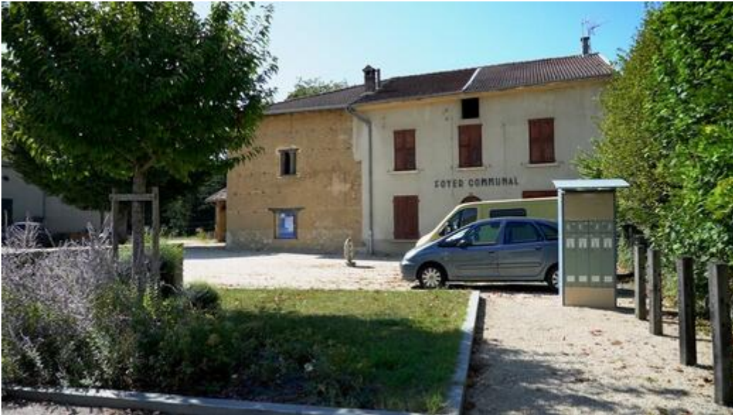
Le foyer communal avant travaux
