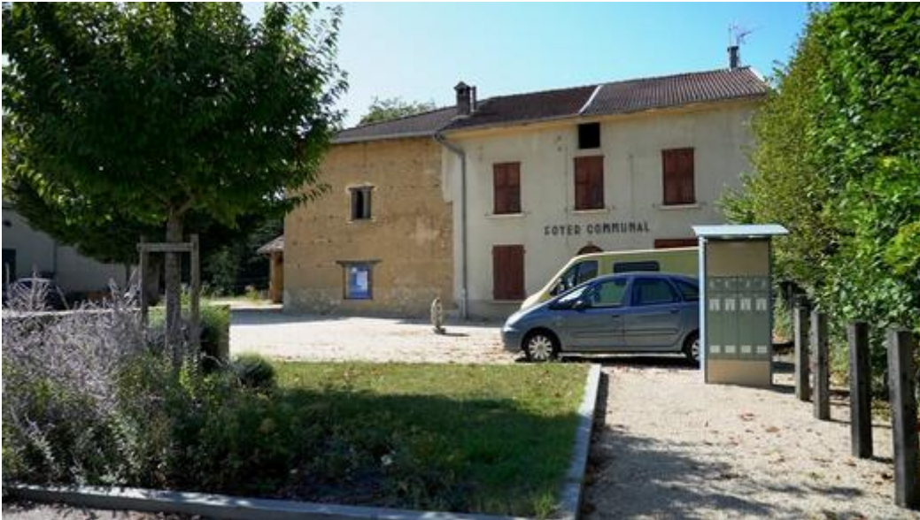
Le foyer communal avant travaux
